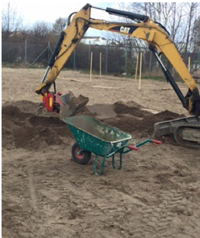
Bild 1. Utjämning av mark och bortforsling av sand.
