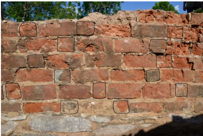
Figur 4. Murverket i den norra korsarmens östra sida. Foto: Lödöse museum, 2019.
