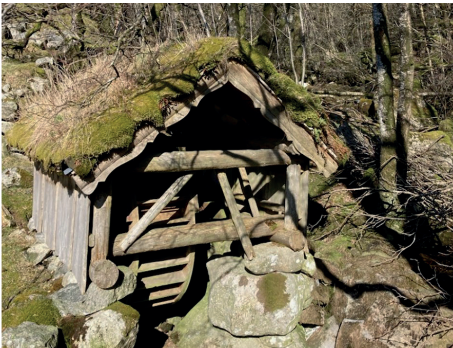
Fig. 1. Hjulhus med vasshjul ved ein bekk på garden Nordland i Sandnes kommune. Bak huset finn ein veita der vatnet vart ført til hjulet. Foto: Ingrunn Vassbø Særheim.
