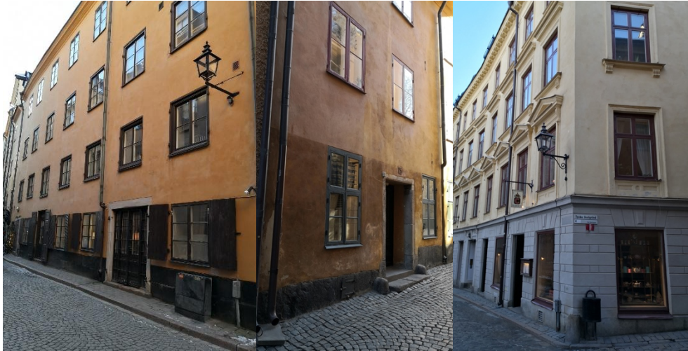
Bild 16. Österlånggatan 16 (vänster), Baggensgatan 15 (mitten) och Svartmangatan 23 (höger). Foto: Anders Ahlford, 2024.
