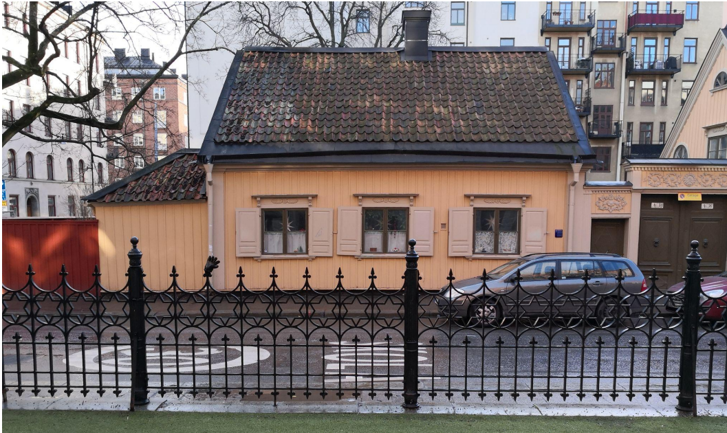
Bild 5. Nils Girings två malmgårdar låg på var sin sida av Tjärhovsgatan i hörnet av Nytorpgsgatan. De brann ner 1723. På norra sidan ligger nu Katarina Norra skola, och på södra sidan uppfördes ett par år efter branden en ny malmgård, som finns kvar än i dag. Foto: Anders Ahlford, 2025
