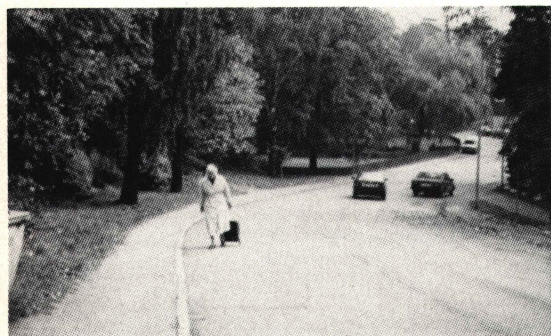
Lutande trottoar i tvärlend gör att äldre väljer att gå i körbanan.
