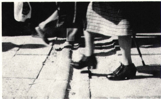
Ränna för ytaavvattnning i kombination med vägarbete. Betongplattor är borttagna.
