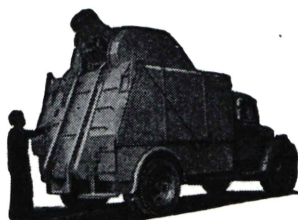
NORBA-bil typ HB med automatisk kärllömmare, för sopor som ej erfordrar höggradig komprimering. Lastar upp till 15 kbm.
