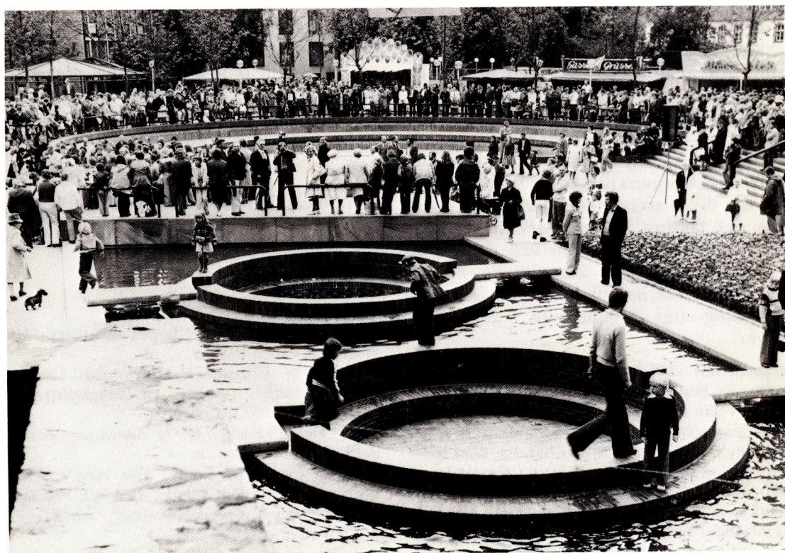
Utemiljö med springbrunnar på taket till ett parkeringshus i centrala Osnabrück, Margareta Bofinger och medarb. Wiesbaden.
